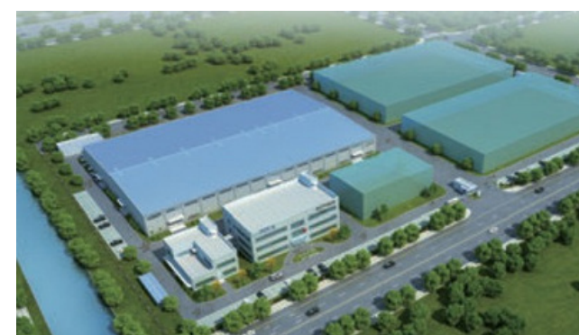
Fase I da planta de produção UCS & Airthink Wuxi (estação aérea inteligente Skid, compressor centrífugo)
